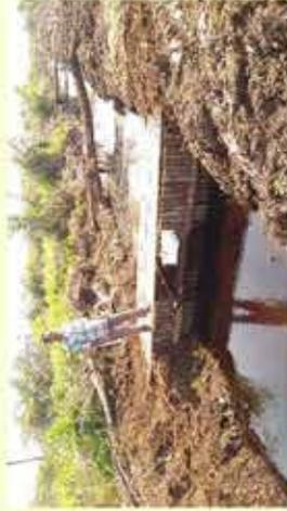
**Sekat Kanal**, untuk meningkatkan kadar air dan Tinggi Muka Air Tanah pada lahan gambut.
