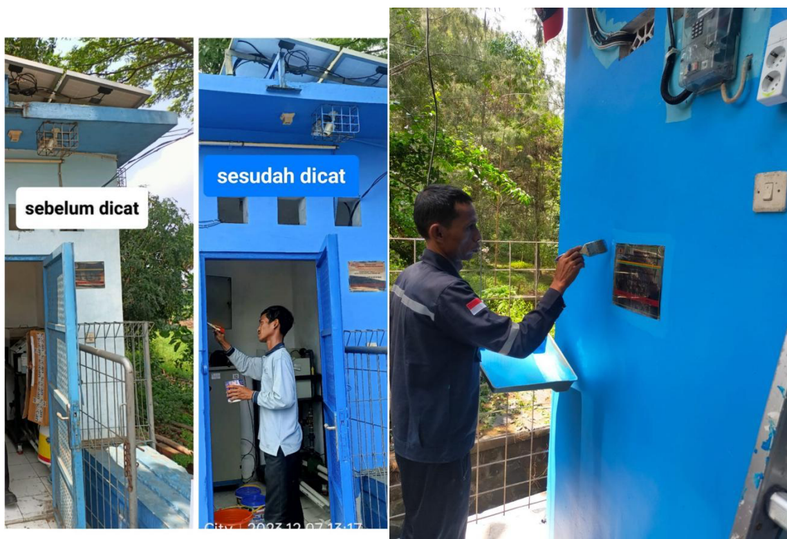
Gambar 9 Proses Perawatan Peralatan Onlimo dan Bangunan Pelindung (Sumber: Direktorat PPA, 2024)
