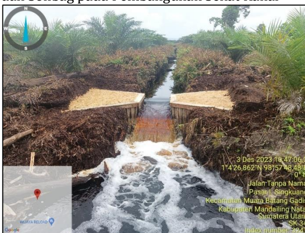
Gambar 19. Sekat Kanal Selesai Dibangun
