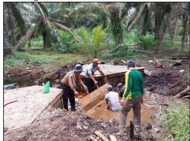
Gambar 18. Pemasangan Papan Peluncur pada Pembangunan Sekat Kanal
