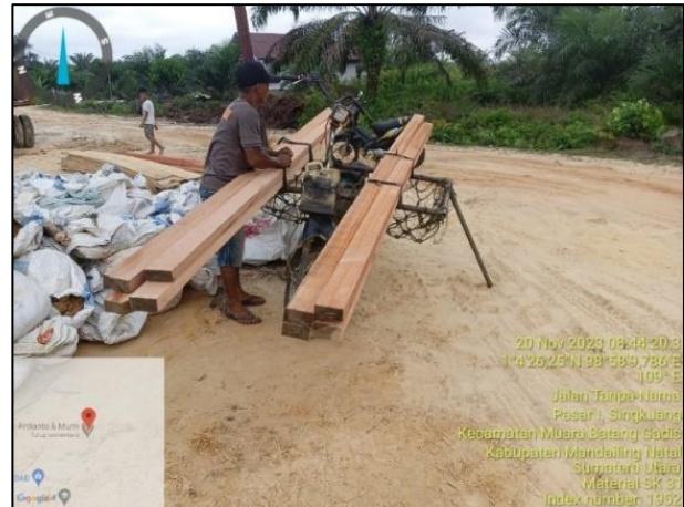
Gambar 16. Mobilisasi Material untuk Pembangunan Sekat Kanal
