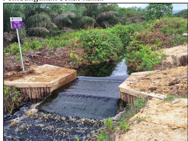
Gambar 20. Sekat Kanal Selesai Dibangun
