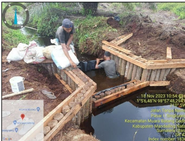
Gambar 17. Pemasangan Cerucuk, Geotextille dan Soilbag pada Pembangunan Sekat Kanal
