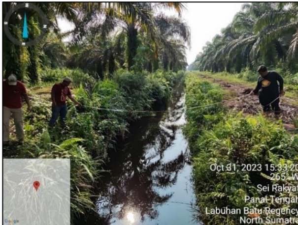
Gambar 15. Mutual Check Pra Pembangunan Sekat Kanal
