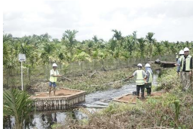
Pembangunan Sekat Kanal dan Pemasangan FDRS
