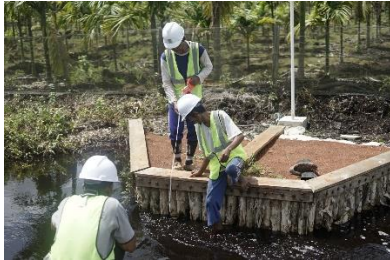
Pembangunan Sekat Kanal dan Pemasangan FDRS
