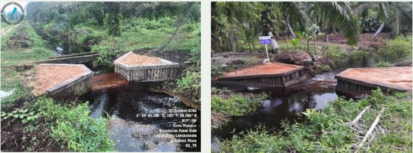
Gambar 53. Pembangunan Sekat Kanal di Sumatera Utara (Sumber : Direktorat PKEG, 2024)
