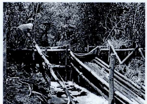
Gambar 9. Contoh tipe sekat satu lapis dengan pelimpasan ( spillway )
