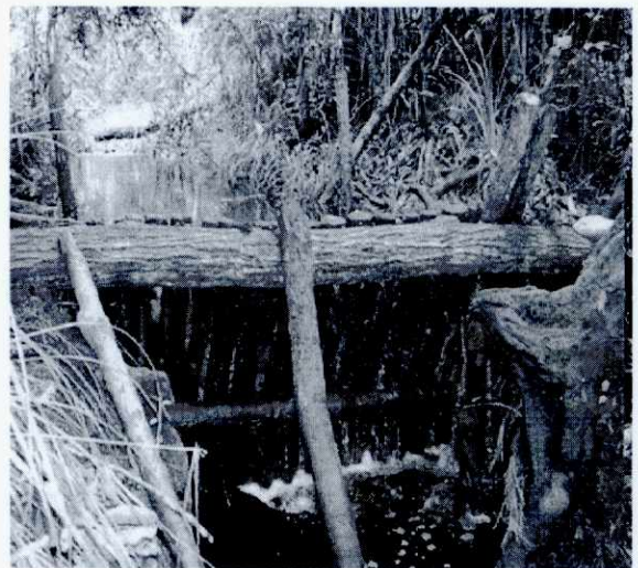
Gambar 8. Contoh tipe sekat satu lapis tanpa pelimpasan ( spillway )
