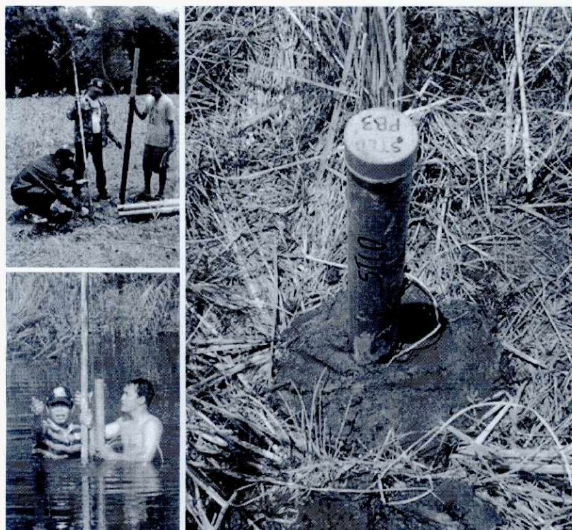
Gambar 27. Proses penyiapan sumur pemantauan
