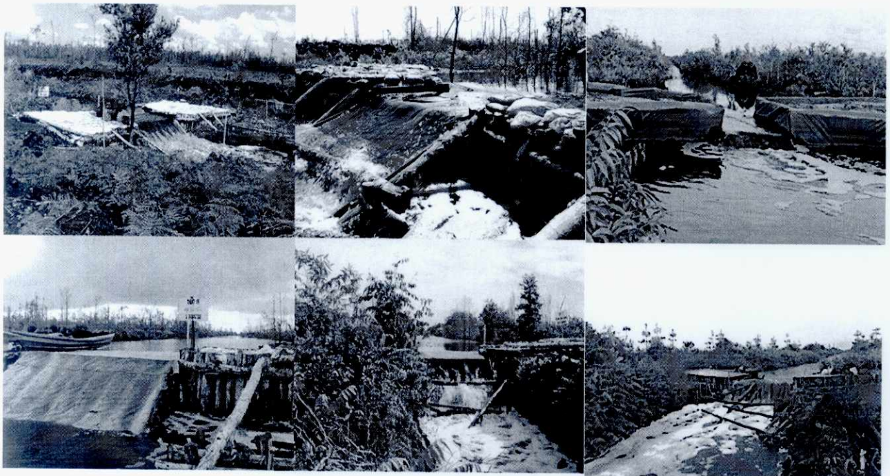
Gambar 14. Contoh Sekat Kayu Dua Lapis dengan Pelimpasan ( spillway )
