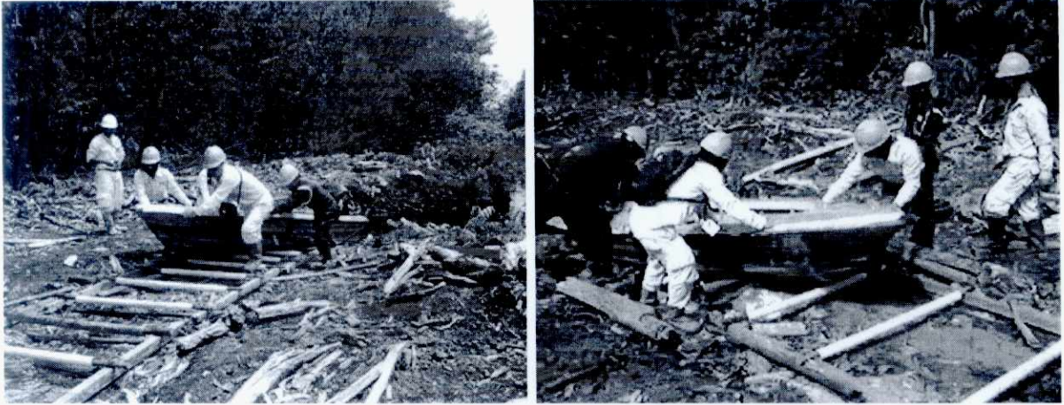
Gambar 6. Contoh gelindingan ( ramp/roller ) di sekat kanal tanpa pelimpasan.
